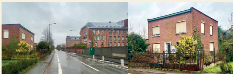
1 Démolition rue de l'Abbé Six Création d'un parking
