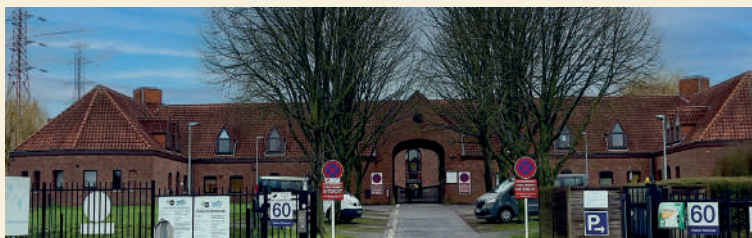
5 Papillons blancs Création de 12 logements
