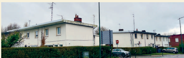
3 Rénovation énergétique de la résidence de la Croix Blanche
