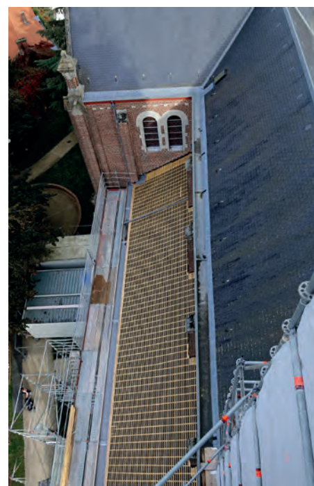
L'échafaudage sera démonté d'ici fin d'avril.
