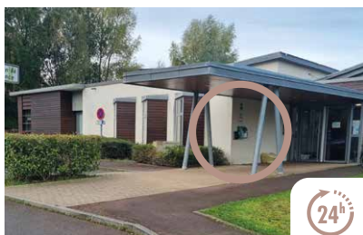
Sur le mur d'entrée de la Maison de l'Enfance, 2 allée du Grand Cerf
